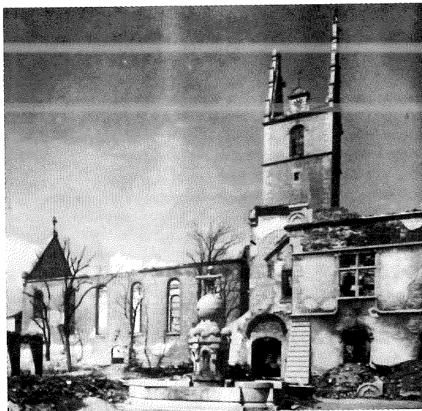
Friedrichshafen: zerstörte Nikolauskirche (1945)
